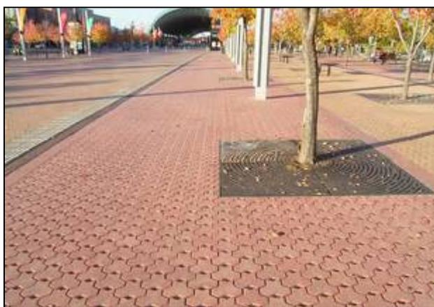
Figura 16 - Esempio di pavimentazione drenante
