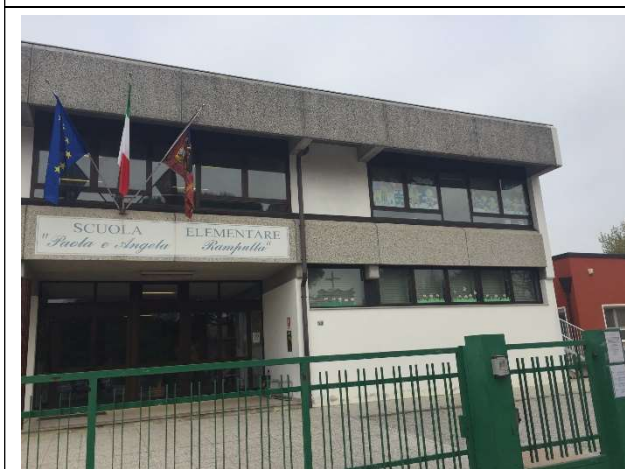
Vista esterna edificio
