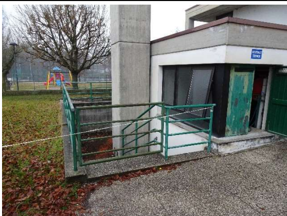
Ingresso centrale termica
