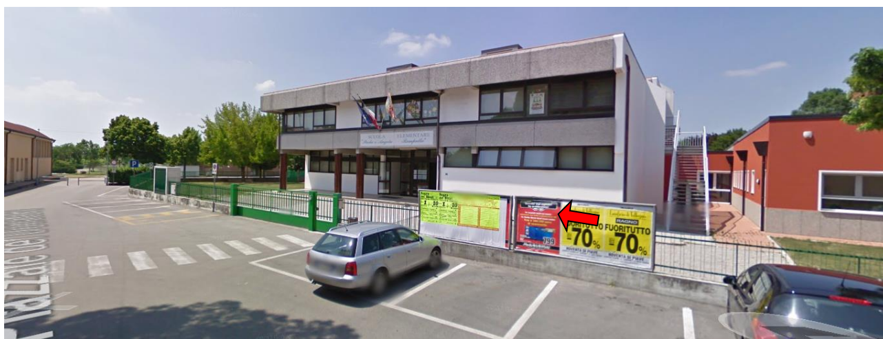
Cancello carraio per accedere all'area di cantiere
