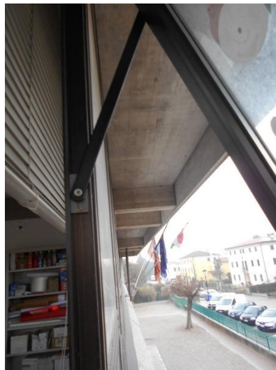
Aggetto in copertura lungo la facciata est
