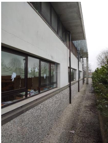
Particolare marciapiede e aiuola lato ovest (vista da nord)
