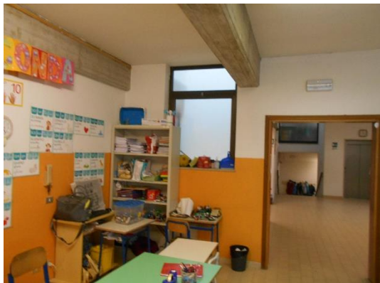
Finestra interna affacciata su cavedio
