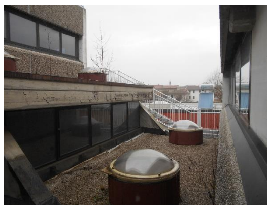
Lucernari lato nord, sopra la palestra presente al piano terra
