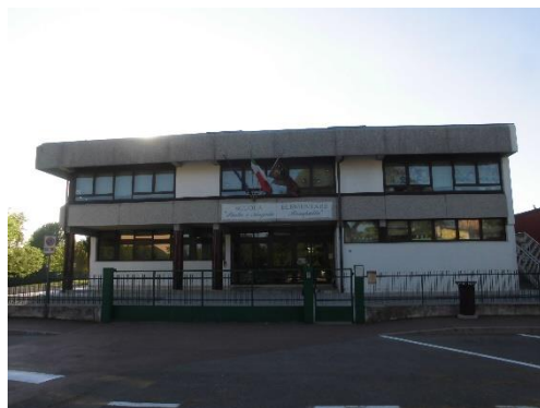
Vista est con ingresso principale pedonale e cancello carrabile
