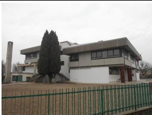
Facciata sud con accesso alla centrale termica
